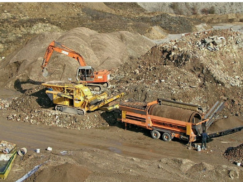
Mobile Aufbereitungsanlage für Bauabfälle
