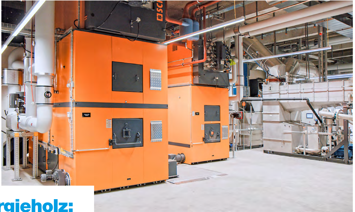
Heizzentrale des neuen Wärmeverbunds Uster Nord mit 2,9 Megawatt Leistung aus Energieholz. Quelle: Energie Uster AG
